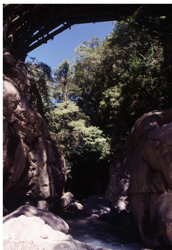
楠溪橋跨越在岩壁逼近的陡峭峽谷
