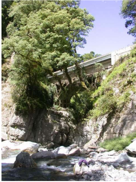
楠溪橋跨越處正好由較寬的 V 形谷，轉換成深邃的陡峭峽谷處
