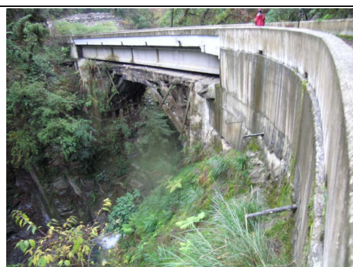
水泥橋直接架在木橋上的楠溪橋
